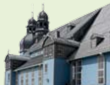
Baustelle Marktkirche Clausthal
